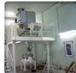
▶ Installation poudre de lait
