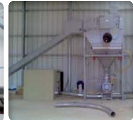
▶ Déconditionnement de ciment avec transfert pneumatique
